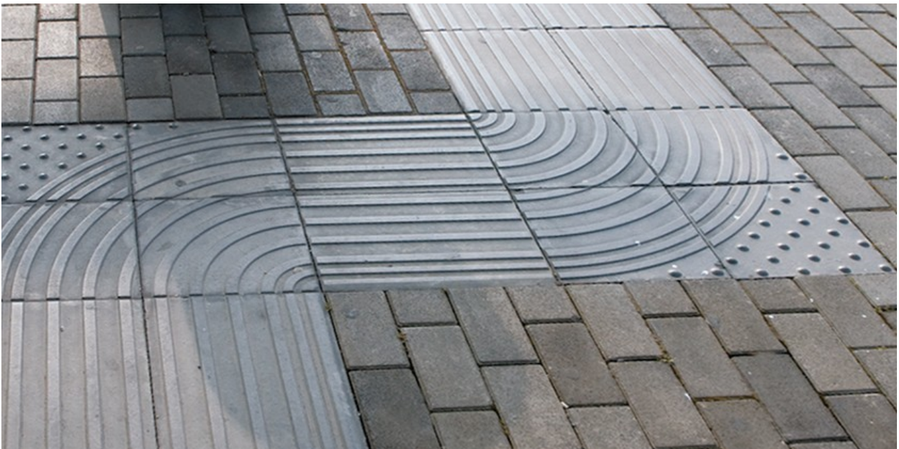
(Esempio di sistema di segnalazione per non vedenti – sistema LOGES LVE)
